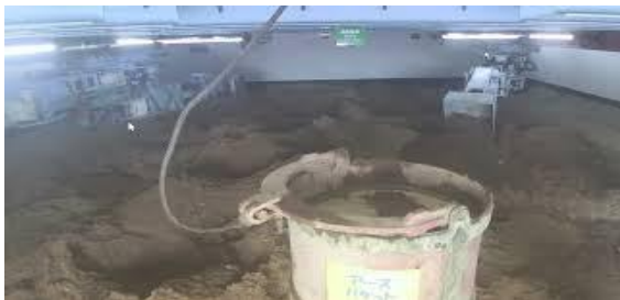
自動運転システムによる二台のケーソンショベル自動掘削
